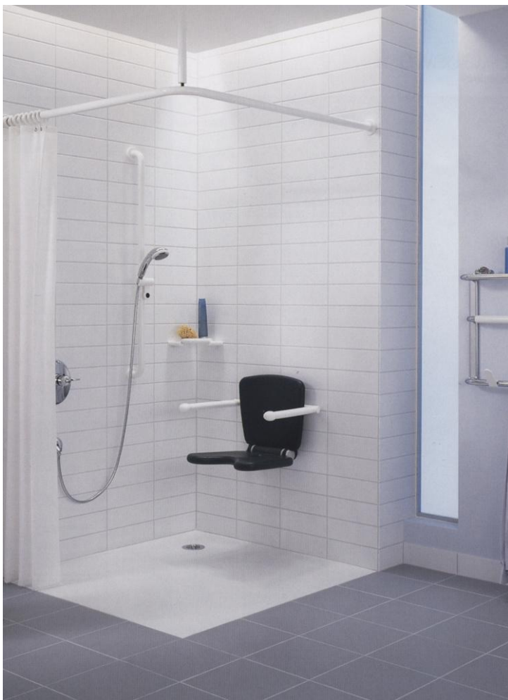
Nízka bezbariérová vanička v sprchovacom kúte je odvodnená do podlahového vpustu. (zdroj: Firma HEWI)
