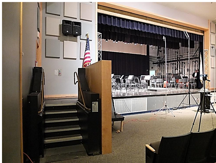
Zvislá zdvíhacia plošina so zasúvacími schodmi (Sála Waltham, USA)
