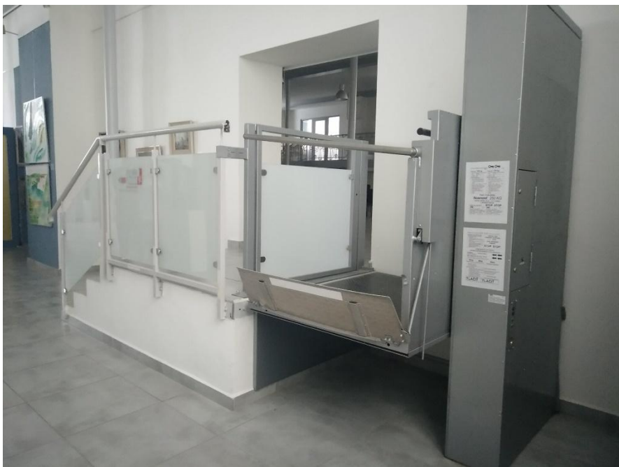
Zvislá zdvíhacia plošina, na ktorej treba otočiť vozík o 90°, musí mať podlahovú plochu najmenej 1400 mm x 1400 mm (Deutsches Museum, Mníchov)
