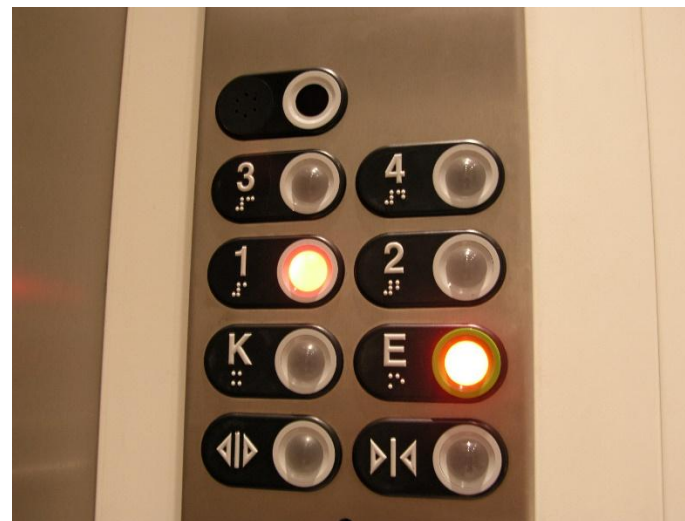
Ovládací panel výťahu, ktorý je čitateľný vizuálne aj hmatovo
