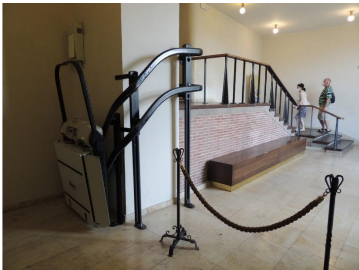
Bezbariérové sprístupnenie pomocou dômyselne navrhutej šikmej schodiskovej plošiny a výtahu k vyhliadke (Staromestská radnica v Prahe)
