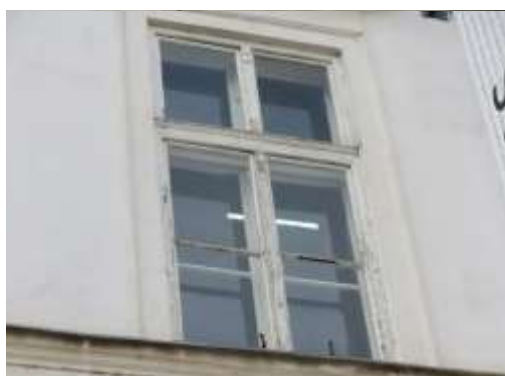
staré a nové okno
