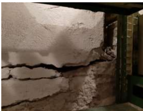
Trhlina v základe muriva depozitného skladu, Zvonárska 19
