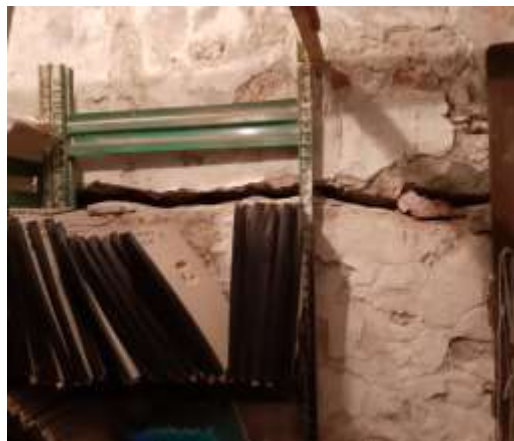
Trhlina v základe muriva depozitného skladu, Zvonárska 19
