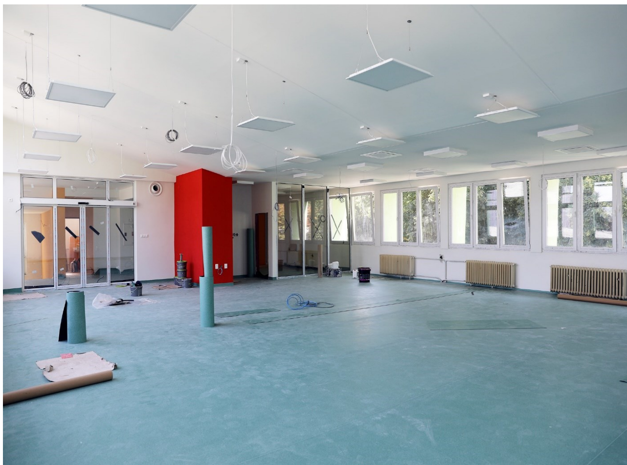
Obrázok 6 Rekonštrukcia študovni OKIS
